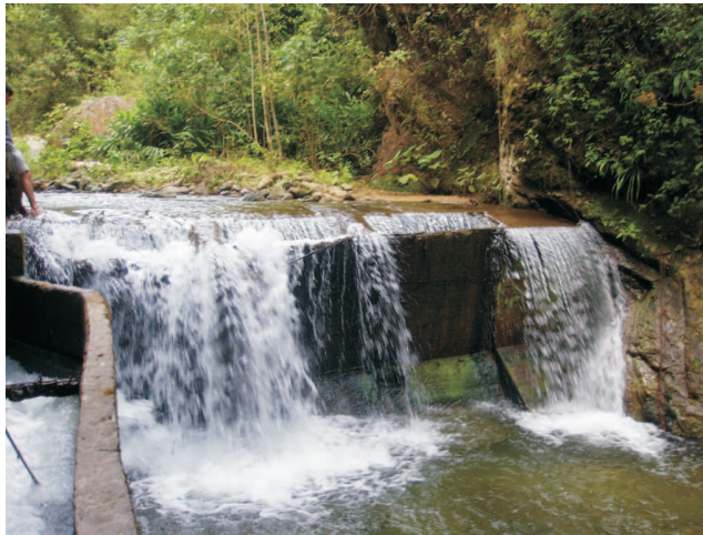
SOCAVACIÓN DE LA ESTRUCTURA
